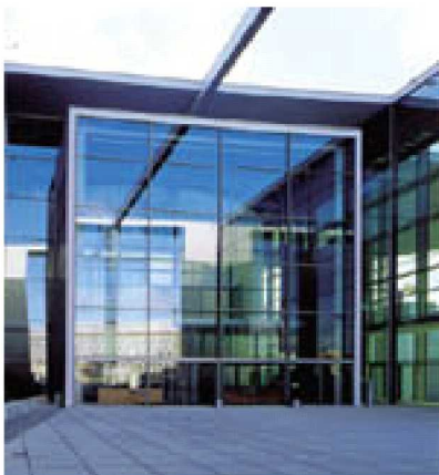
Marie-Elisabeth-Lüders-Haus - Berlin, Allemagne Architecte: SBA Stephan Braunfels Architekten
